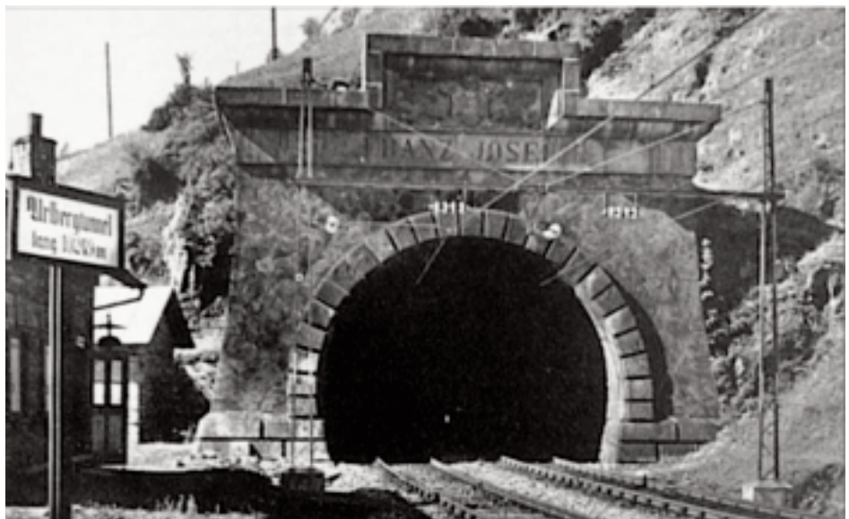
Nach der Tunnelinspektion. Nordseite.
