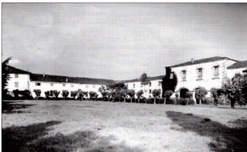
FLAMBRO. Immagine storica del paese di Flambro. Villa Savorgnan. Collezione di Mario Salvalaggio.
